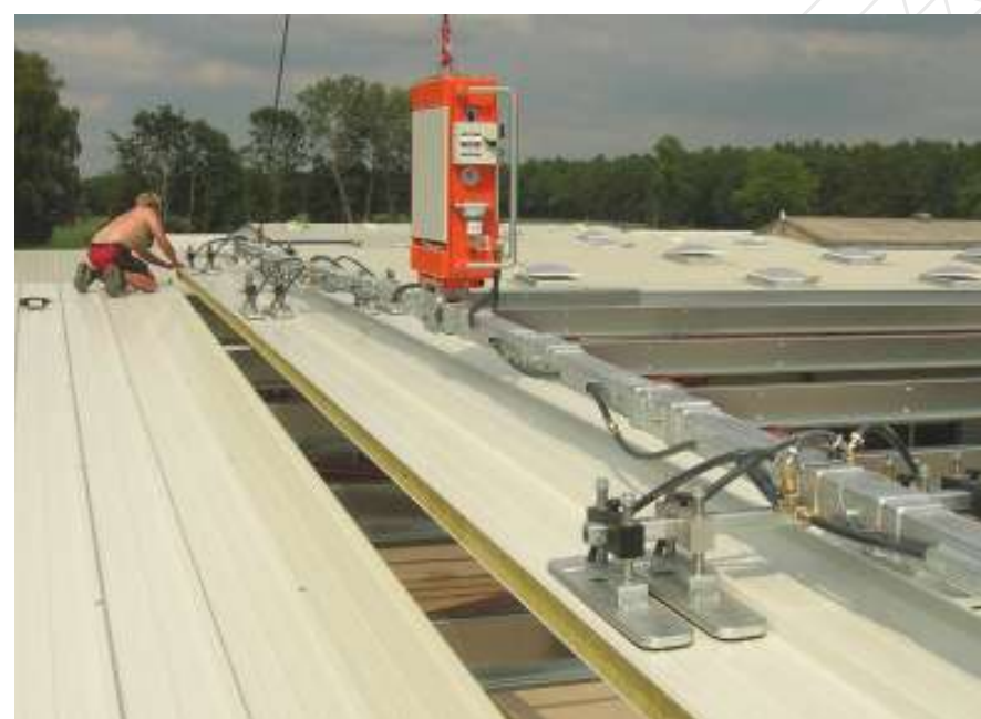
Монтаж кровельных сэндвич-панелей
