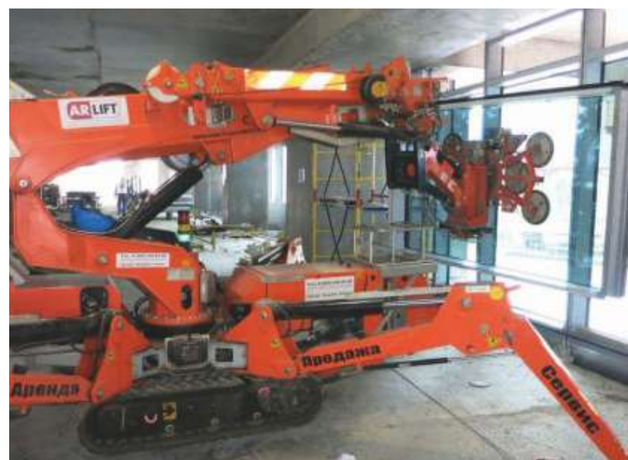
Монтаж стекла изнутри
