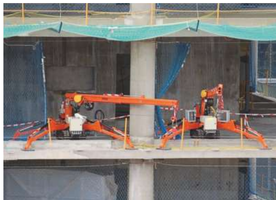
Работа с перекрытия
