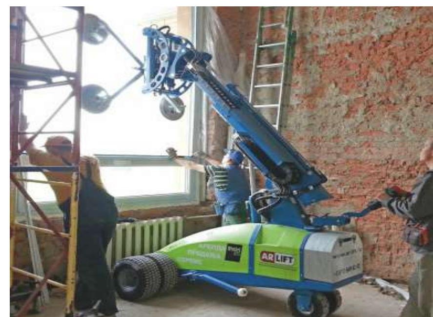
Остекление внутри помещений
