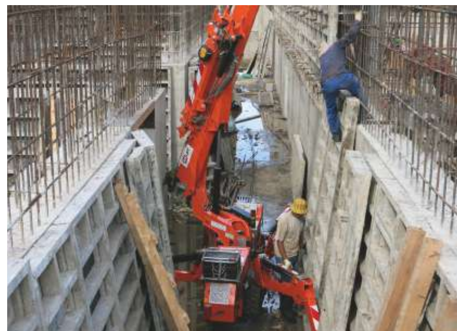
Монтаж опалубки
