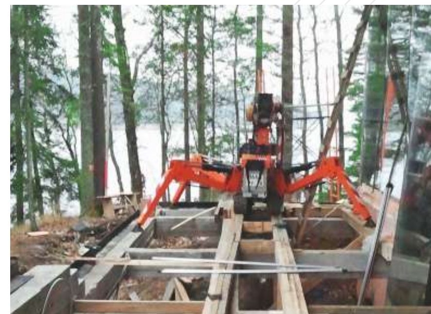
Монтаж в труднопроходимых условиях
